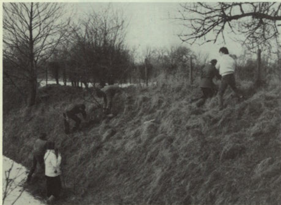
De werkzaamheden in volle gang.
